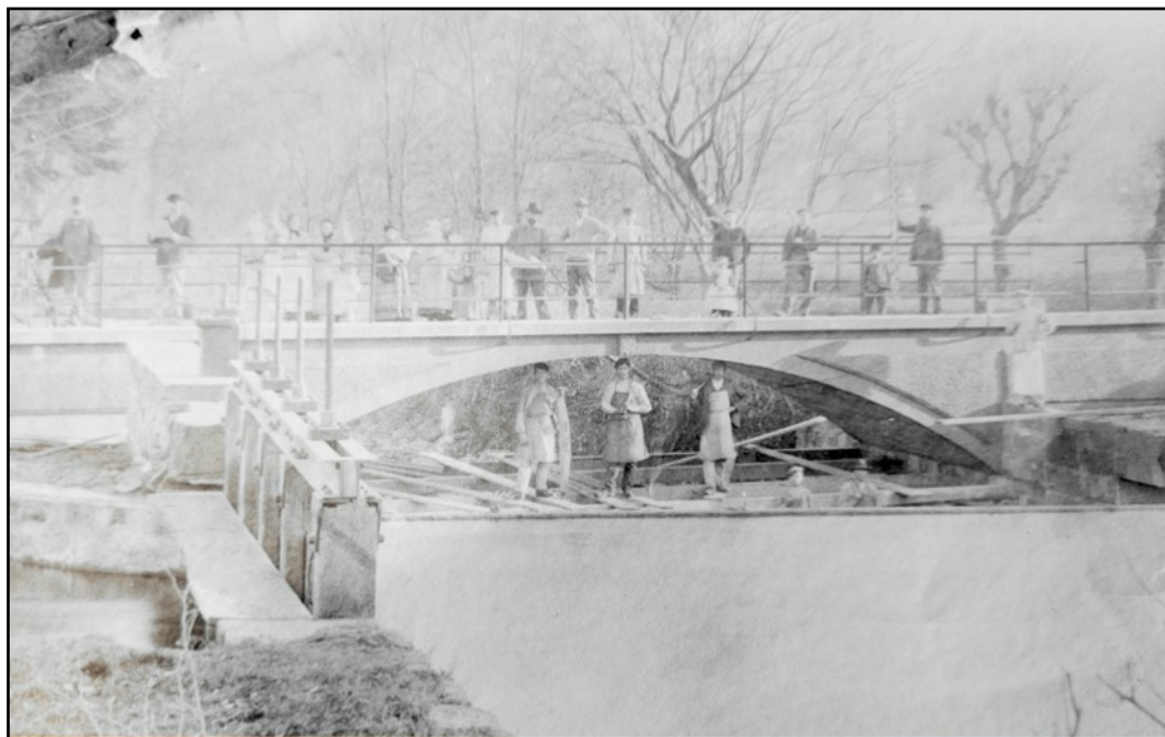
Sur le chantier du pont Monier de Lautenbach Zell en 1899
