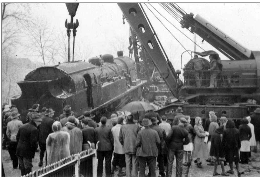
Les deux grues en action sous les yeux d'une foule de spectateurs accourus malgré la pluie
