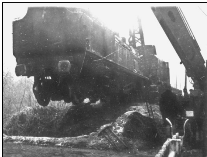
La locomotive est soulevée par les deux grues
